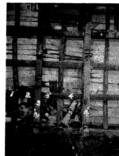
写真-4 気泡モルタル注入用パイプと鏡止め型わく
